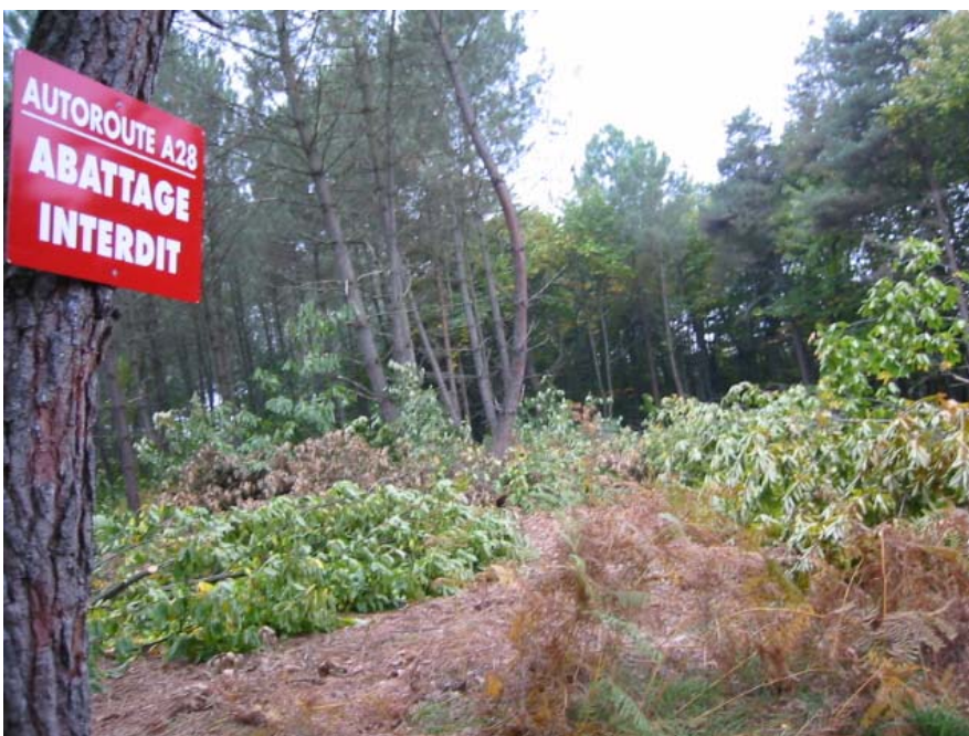
le chantier d'abattage de la forêt de Bercé.
